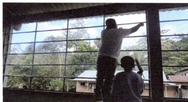
Foto 6: Colocando los vidrios en cada ventana, tanto de frente y atrás de aulas.
