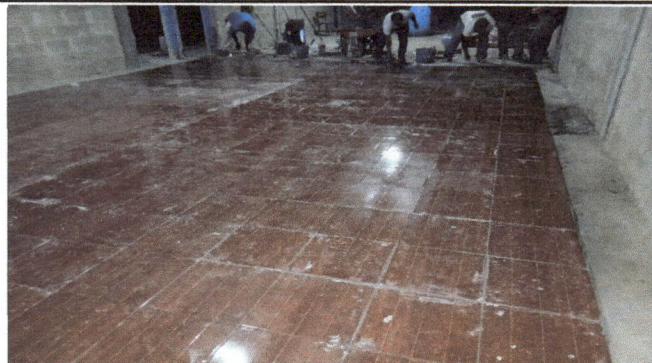
Foto 2: El avance de la ejecución del piso cerámico en las tres aulas del establecimiento educativo.
