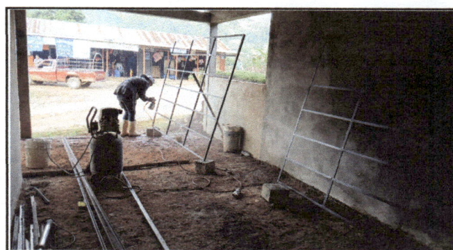
Foto 4: El proceso de la elaboración de balcones para ventanas con vidrios.
