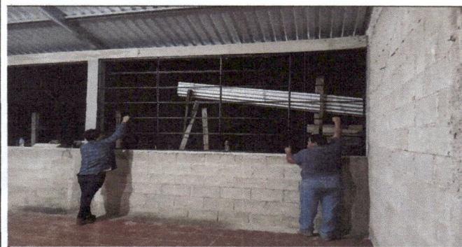
Foto 5: Instalando balcones en cada ventanas de las tres aulas del establecimiento educativo.
