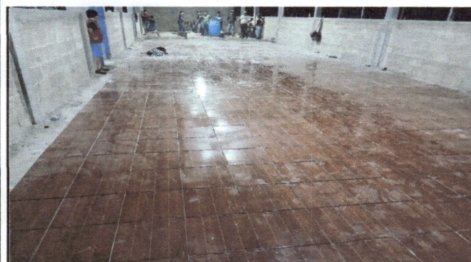
Foto 3: Concluyendo la sustitución del piso de concreto a piso cerámico.
