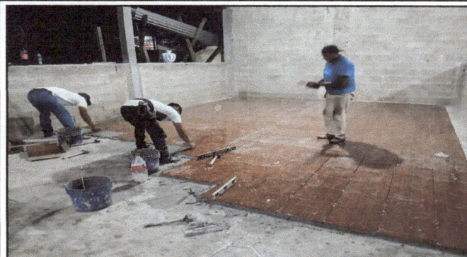
Foto 1: Inicialmente se muestra la colocación del piso cerámico en las instalaciones del centro educativo.
